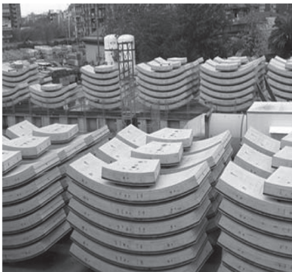
2 pav. Plieno ir polipropileno plaušu armuotų segmentų naudojimas tiesiant tunelius
