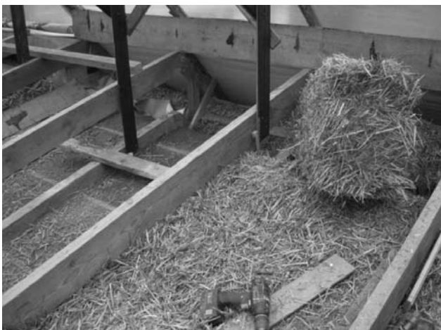
2 pav. Stogo šiltinimas šiaudų ryšuliais
