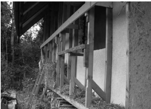
3 pav. Šiaudais šiltinamos sienos karkasas
