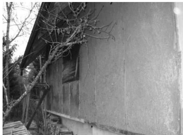
5 pav. Pirmuoju molinio tinko sluoksniu nutinkuota siena
